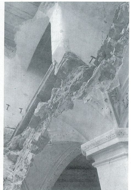
Abb. oben: Salzburg, Altes Borromäum, Stiegenhaus während des Abbruchs 1973; deutlich sichtbar Gewölbetechnik, Stuckprofilaufbau.
