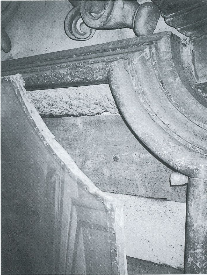
Abb. 63 (oben links): Linker Seitenaltar: Bei der Abnahme des Altarbildes kam die barocke Bretterverschalung zum Vorschein.
