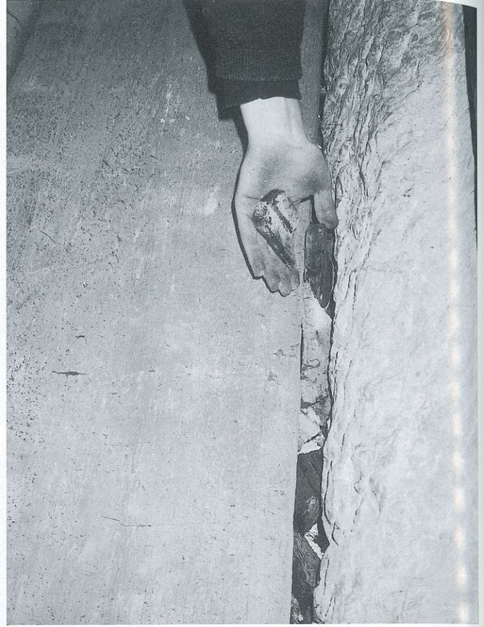
Abb. 64 (oben rechts): Li. Seitenaltar: Im Spalt zum Marmorrahmen ist die originale Holzkohlefüllung als Klimapuffer zu erkennen.
