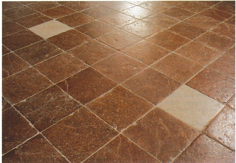
Abb. 40: Marmorplatten des Kirchenfußbodens nach Restaurierung 2001.
