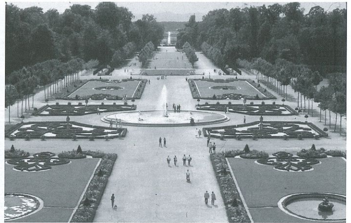
Abb. 3 Mittelparterre im Jahr 1996. Durch den Austausch der brüchigen Linden gegen Jungbäume, deren Höhe auf 9 Meter gehalten wird, sind die ursprünglichen Raumproportionen wieder sichtbar. Die wiederhergestellte Feinstruktur der Parterrebeete hat nunmehr optimale Entwicklungsmöglichkeiten.
